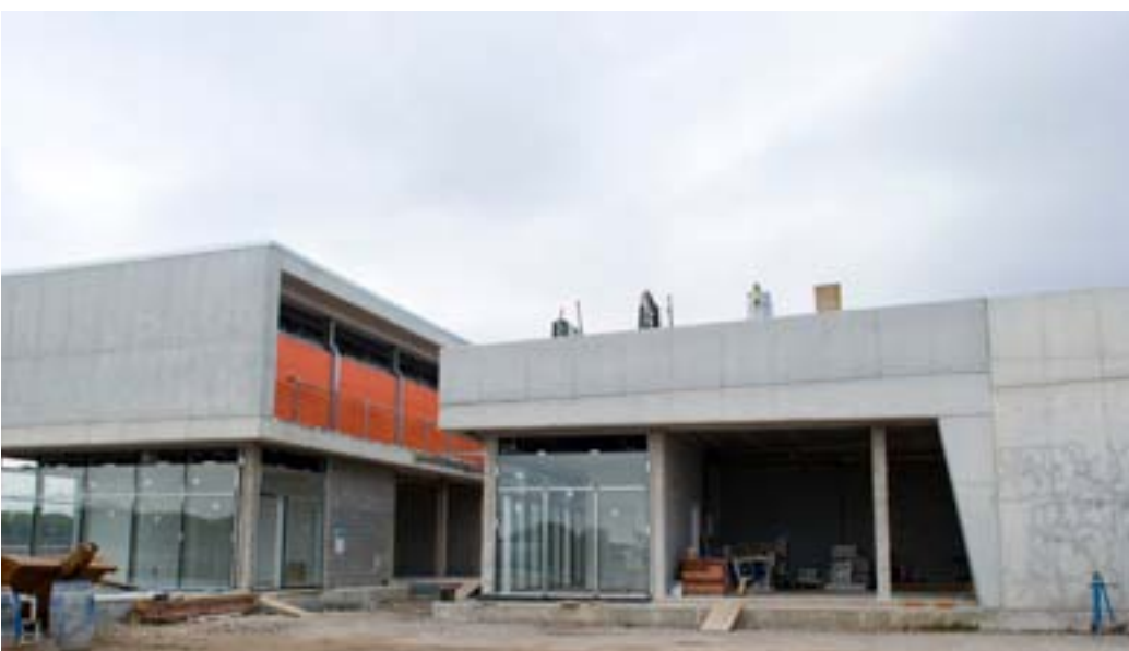
Obres de construcció del Centre de Vela.
