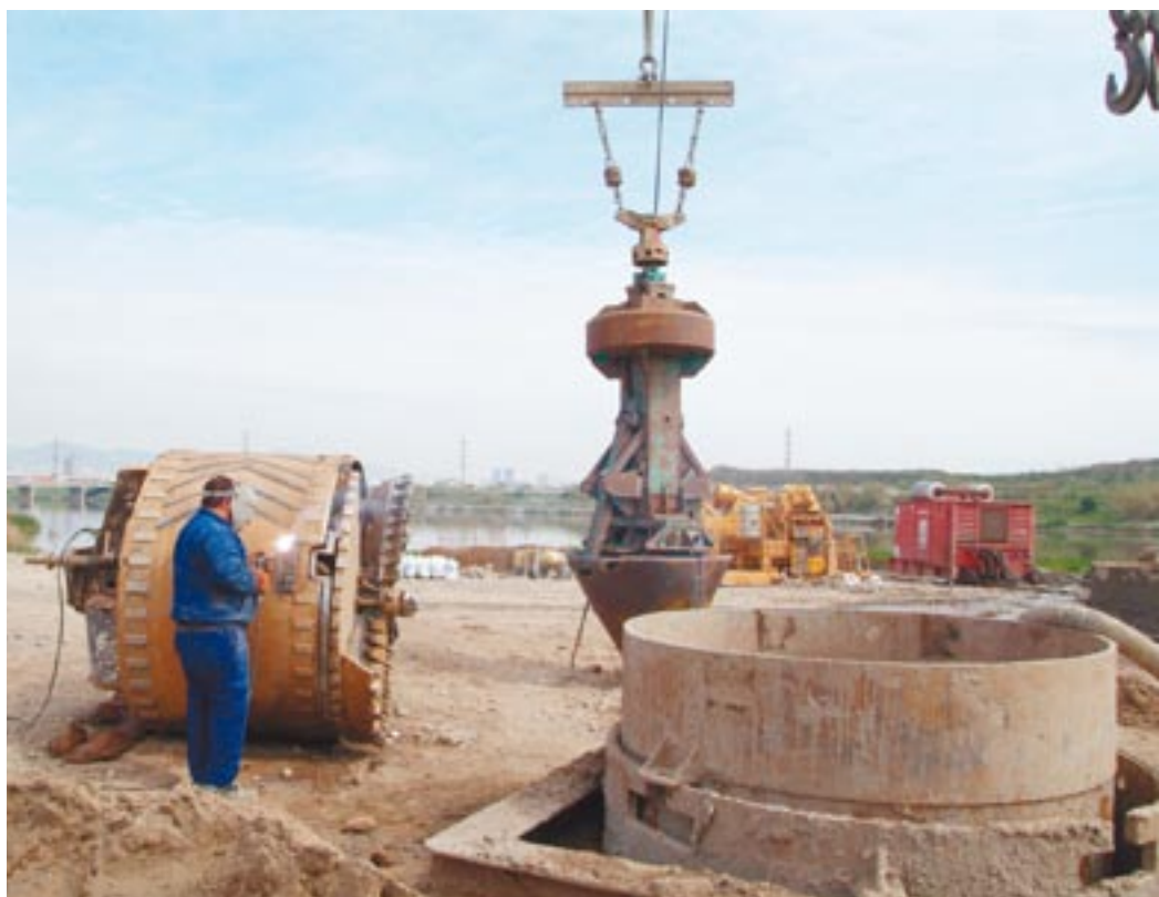
Obres de construcció del pont del Pratenc, que creuarà el Llobregat (en segon pla es veu el riu).
