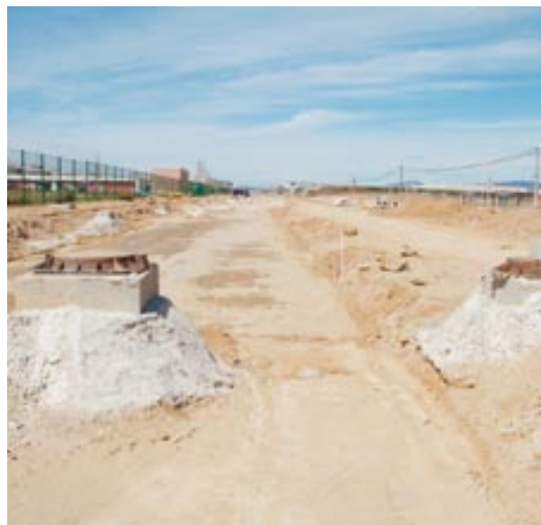
Treballs d'urbanització del carrer 100.
