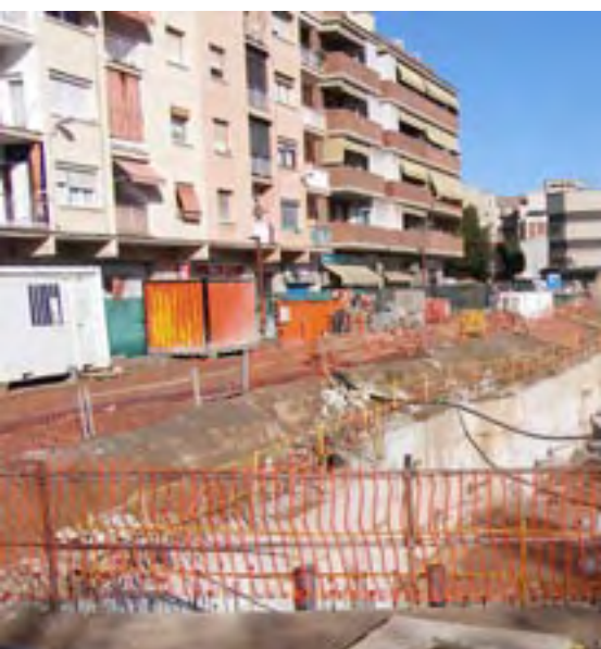
Obras del aparcamiento.
