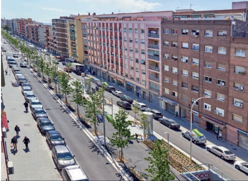
Las aceras laterales también son ahora más anchas que antes de las obras. El tramo central de la avenida sigue el mismo diseño, materiales y tipos de árboles que el resto de Verge de Montserrat reformado anteriormente.
