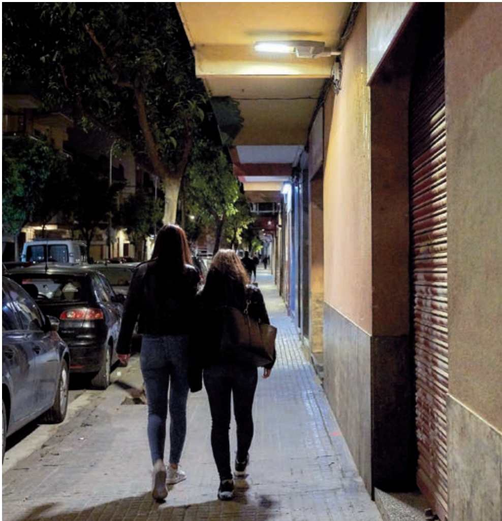
En la calle de Jaume Casanovas, entre Verge de Montserrat y Mestre Estalella, se ha optado por instalar pequeñas farolas de tecnología led bajo los balcones, ya que la frondosidad de los árboles inutilizaba la iluminación de las farolas convencionales.
