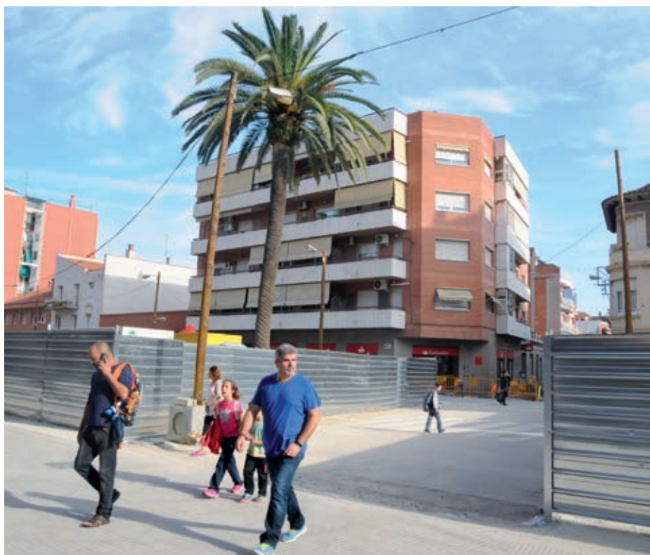
Para cruzar el ámbito de las obras hay que hacerlo por la calle de Frederic Soler. En adelante se estudiará la posibilidad de abrir más pasos además de éste.
