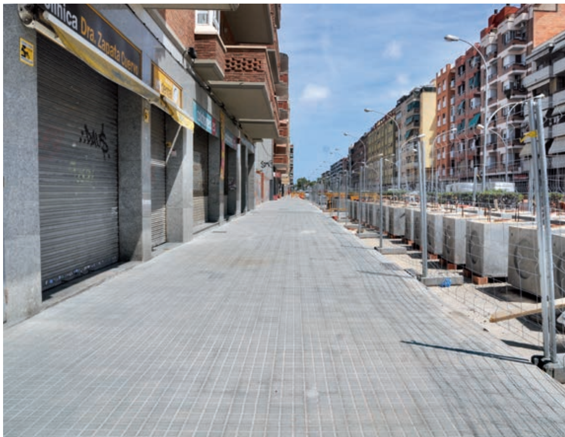
Las aceras laterales de la avenida, más anchas que las anteriores, ya están finalizadas.
