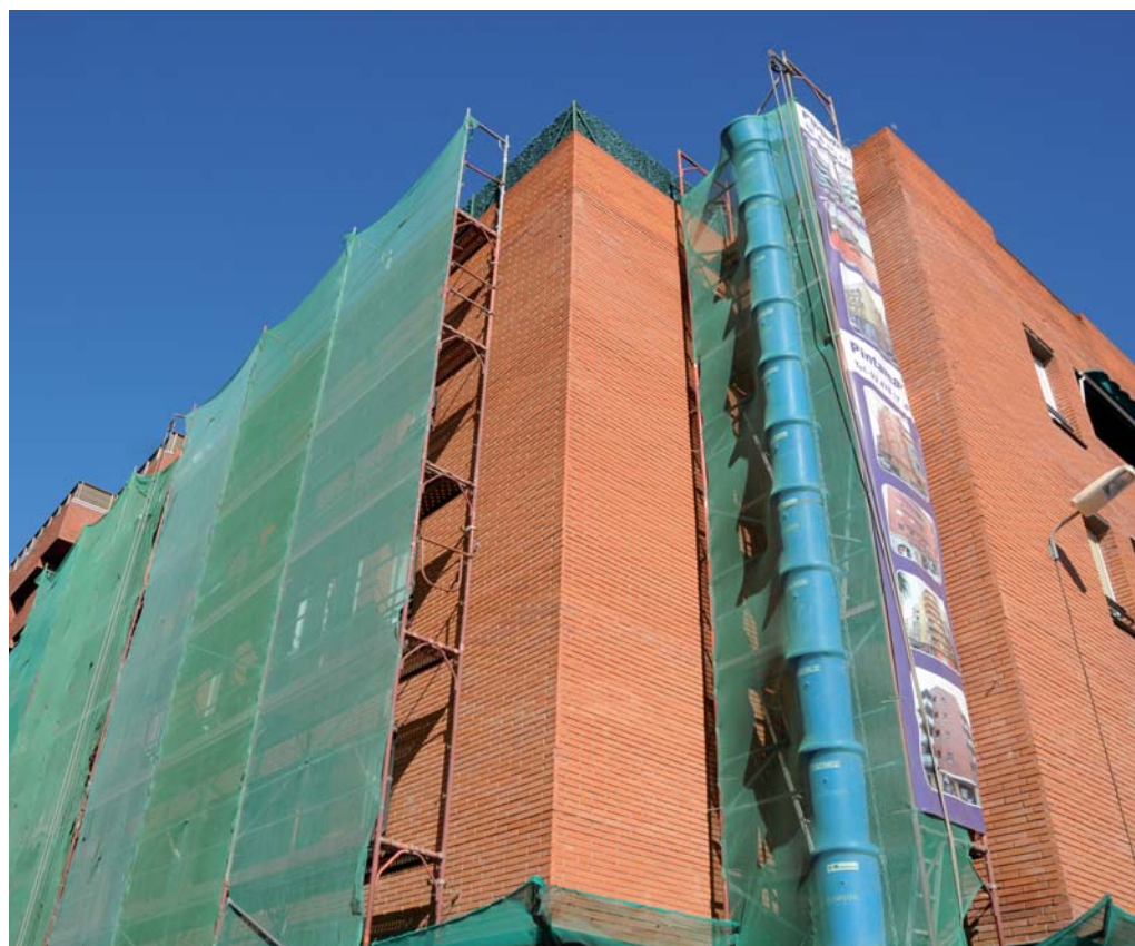
Rehabilitació de la façana d'un dels edificis del Prat que ha rebut subvenció.
