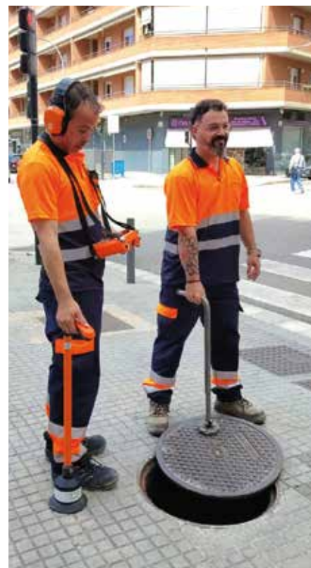
Constant detecció i reparació de fuites
