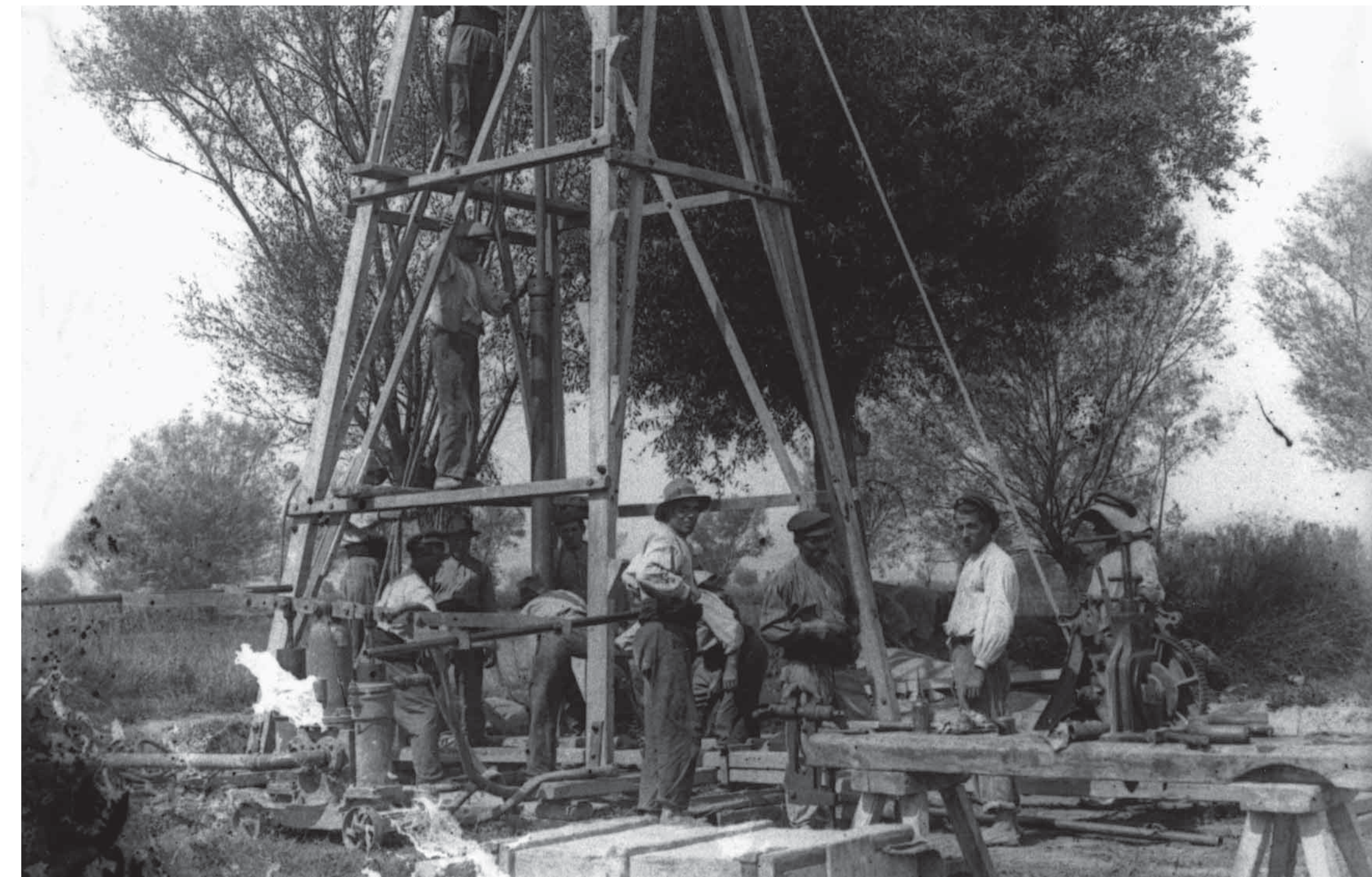
Construcció d'un pou artesià
