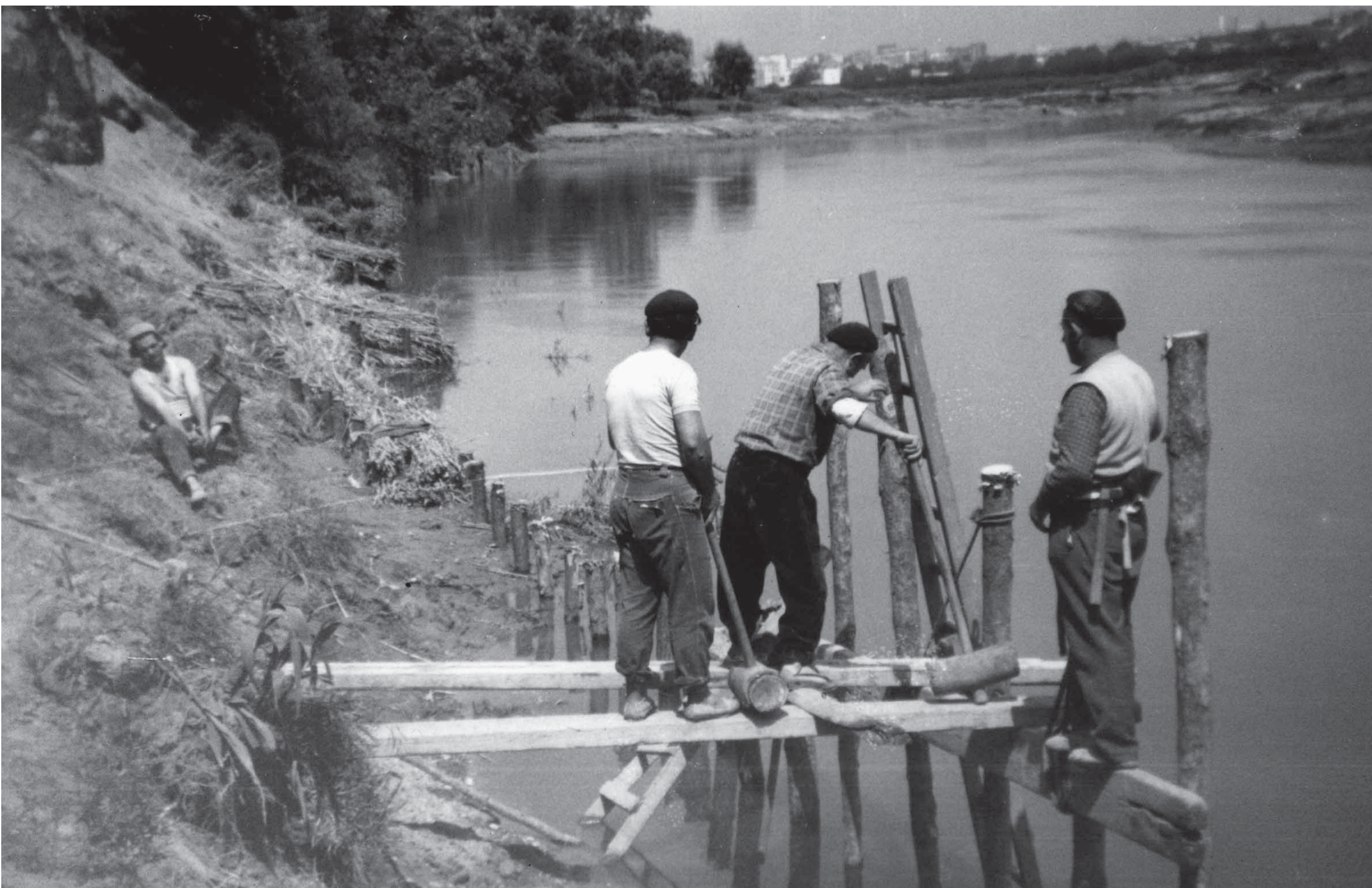
Construcció al costat del riu per reforçar el marge de defensa
