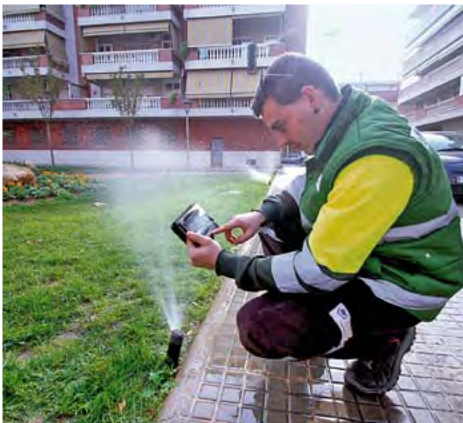
Un operario controla el sistema de telegestión del riego en un jardín de El Prat.
