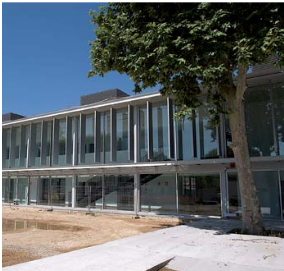
Obras de ampliación y mejora del CAP Doctor Pujol i Capsada.
