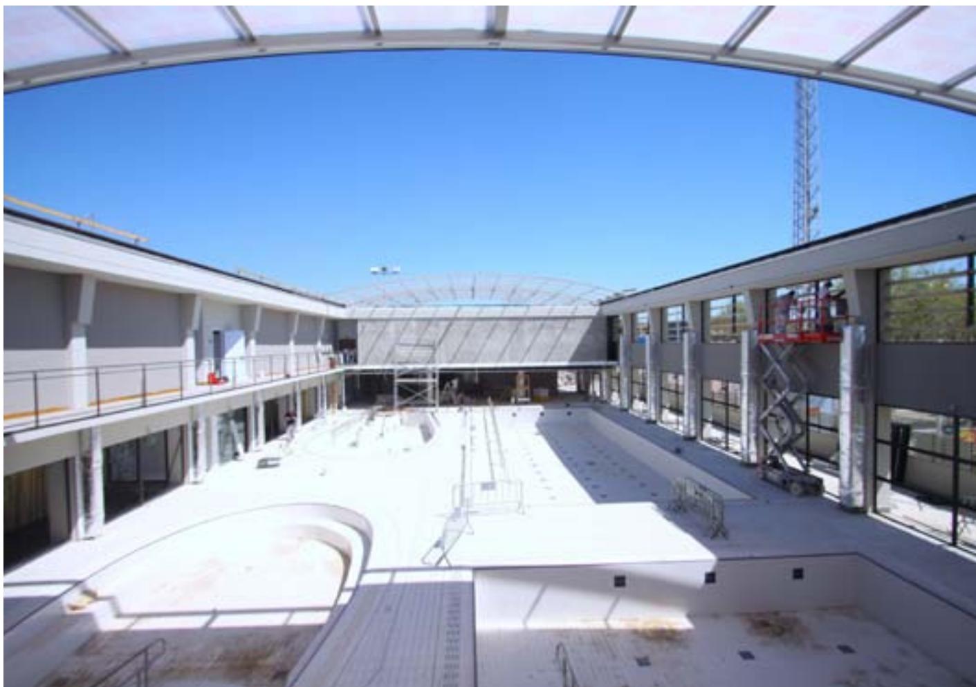
Fotografia presa a principis d'abril, que mostra l'estat de les obres de reparació de la zona de piscines.
