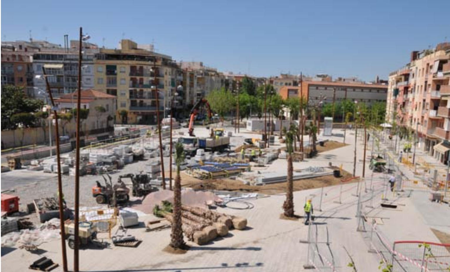
Últimos días de obras de reurbanización de la pl. de Blanes, vista desde el mercado, con la escuela Jacint Verdaguer al fondo.
