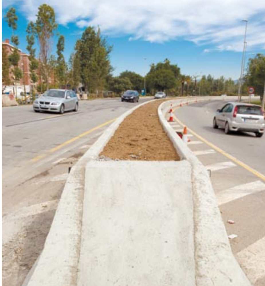
Aspecte de la nova mitjana doble que separa els dos sentits de circulació de la ronda de Llevant.
