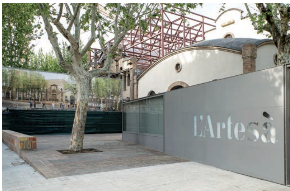
La plataforma d'obra vista de l'entrada serà compartida pel bar i pel teatre, que obrirà d'aquí a un any.
