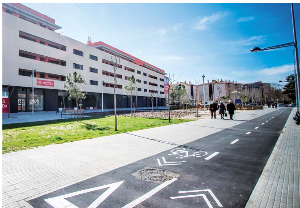
Nueva fachada de la av. Onze de Setembre. Al fondo, el barrio de La Granja.
