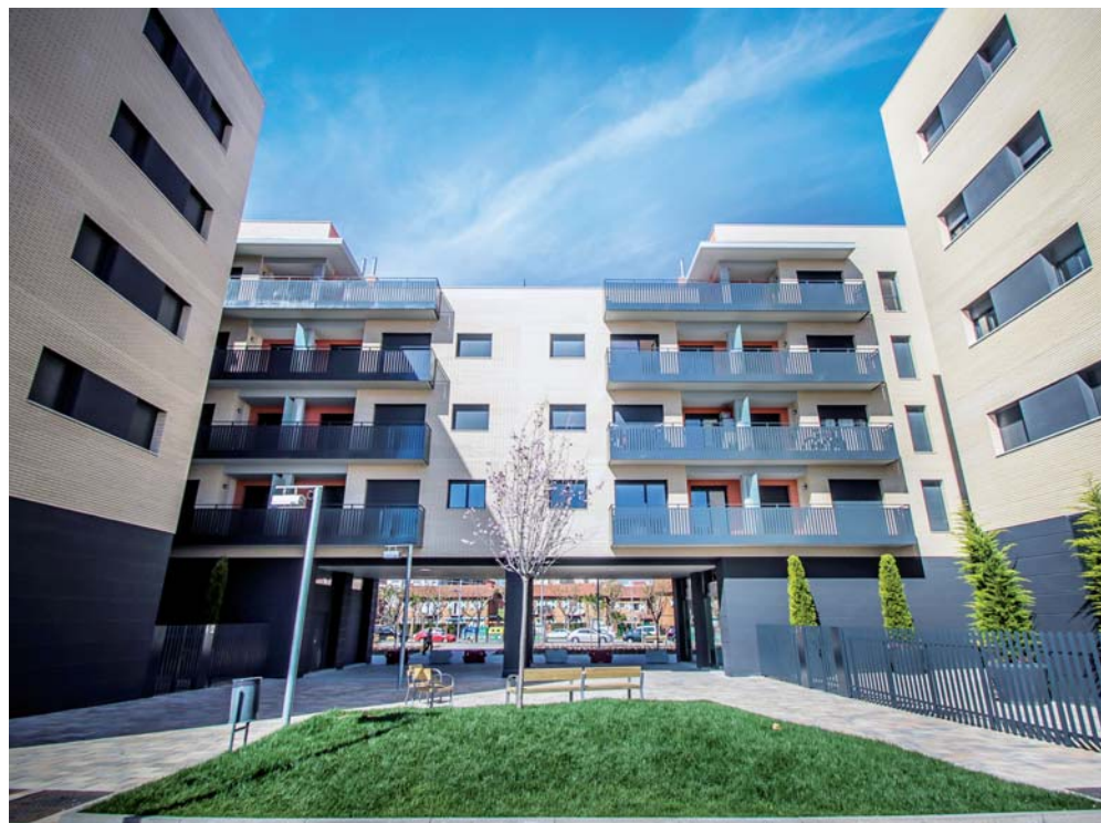
Aspecto del primer edificio acabado. Al fondo, las Casas de la Seda, al otro lado de la av. Onze de Setembre.
