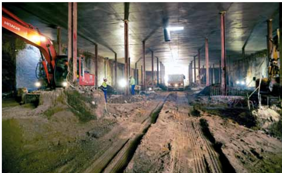
Excavación del recinto bajo la cubierta del aparcamiento. Más información en www.pratespais.com .
