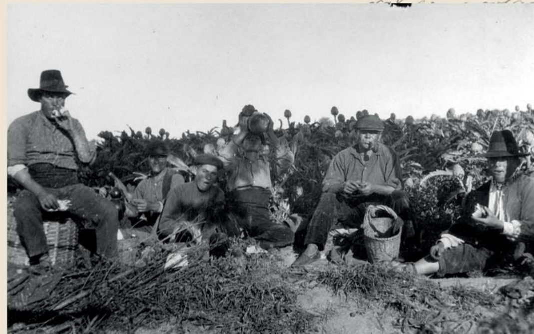
Treballadors menjant al camp. Any 1935 (fotografia AMEP)
