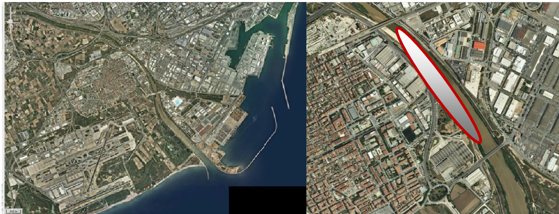
Figura 3.3.1. Tram final del Llobregat al seu pas pel Prat de Llobregat i detall de l'àmbit del parc fluvial
